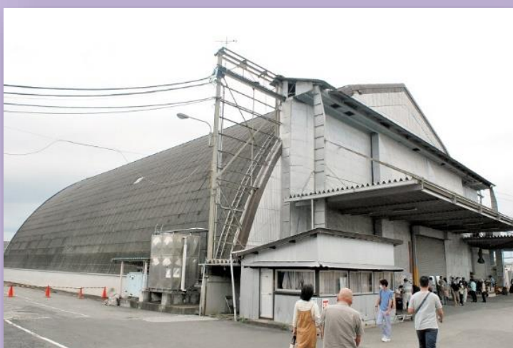
▲旧気球連隊第2格納庫解体前の様子 (令和2年9月25日付『千葉日報』)
