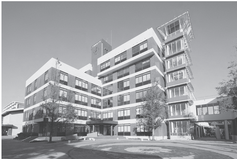
右側のタワーは昨年竣工したエレベータ棟です
